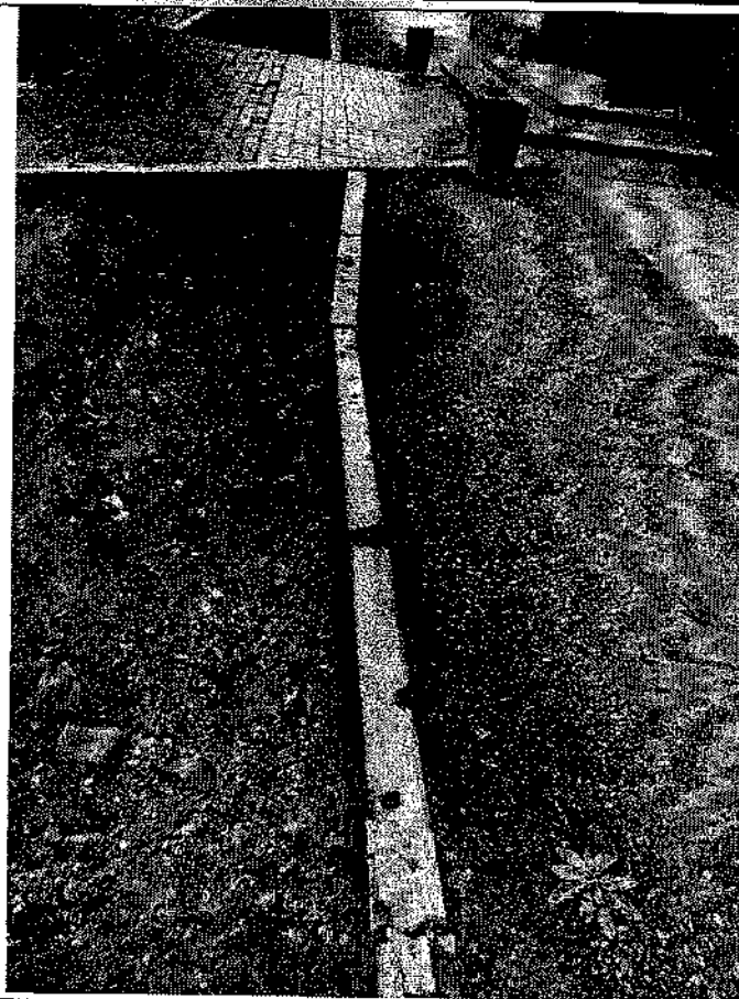
Фото 17. Придомовая территория. Разрушение покрытия тротуаров и бордюров.
